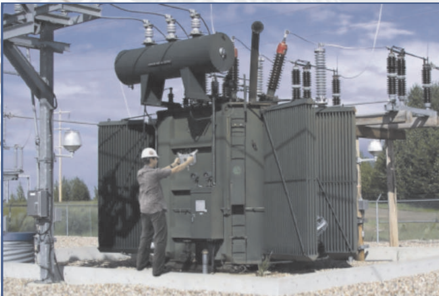
Sistema de Localização e Detecção Portátil de Descargas Parciais em Transformadores de Potência em uso
