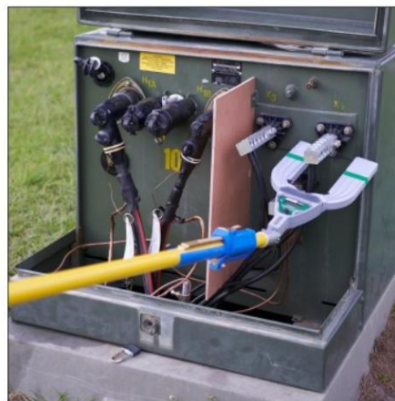
Abertura da garra do Ampstik+ em transformador de solo em bloco
