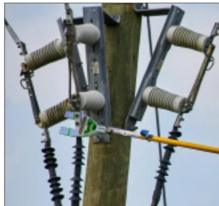
Ampstik+ padrão em interruptor suspenso
