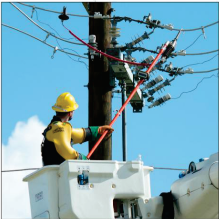
Rádio Voltstik, condutor aéreo
