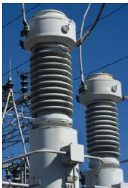
Transformador de Corrente de Alta Tensão
