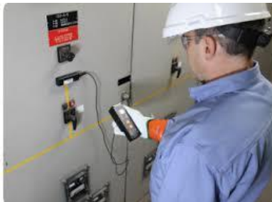
Sensor acústico de contato para detecção parcial de descarga em armários revestidos de metal
